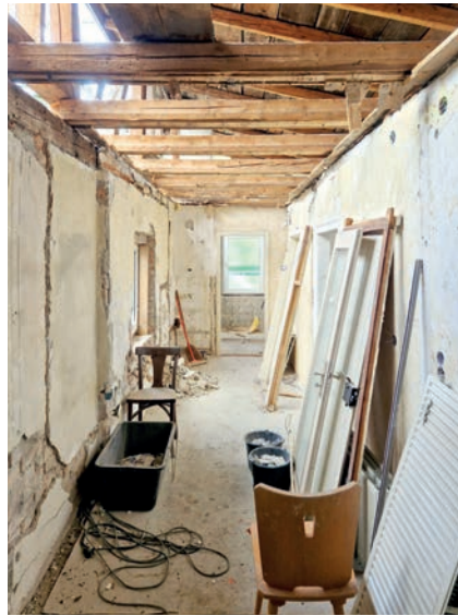
Abb. 8 Foto | Freilegung der Kamine
