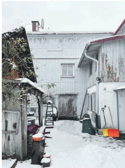
Abb. 3 Hoffassade vor Umbau 2022
