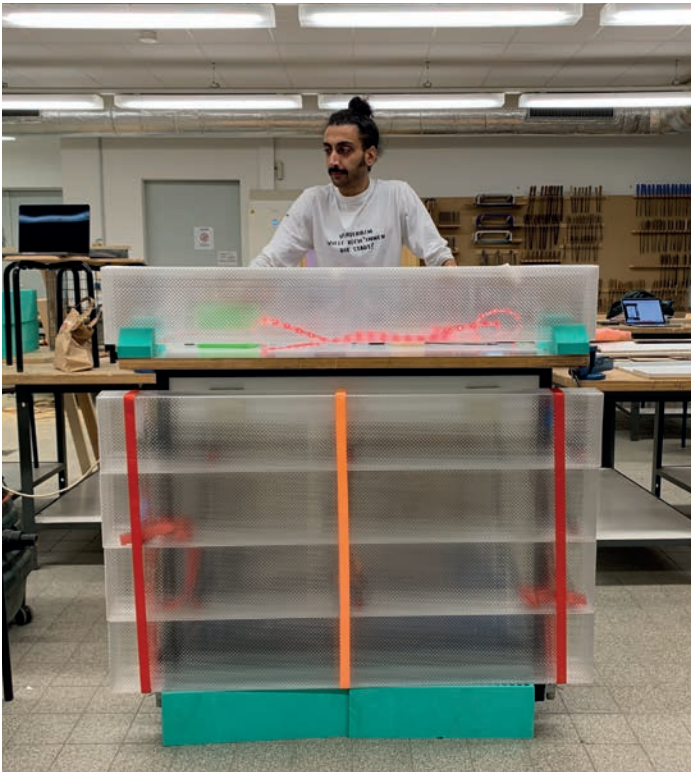
Abb. 6 Ein Kiosk für die Schule in der Bauphase
