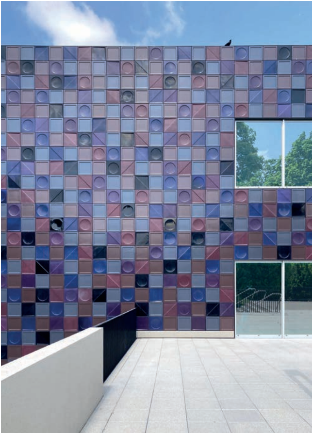
Abb. 9 Ausschnitt der Südfassade der Halle
