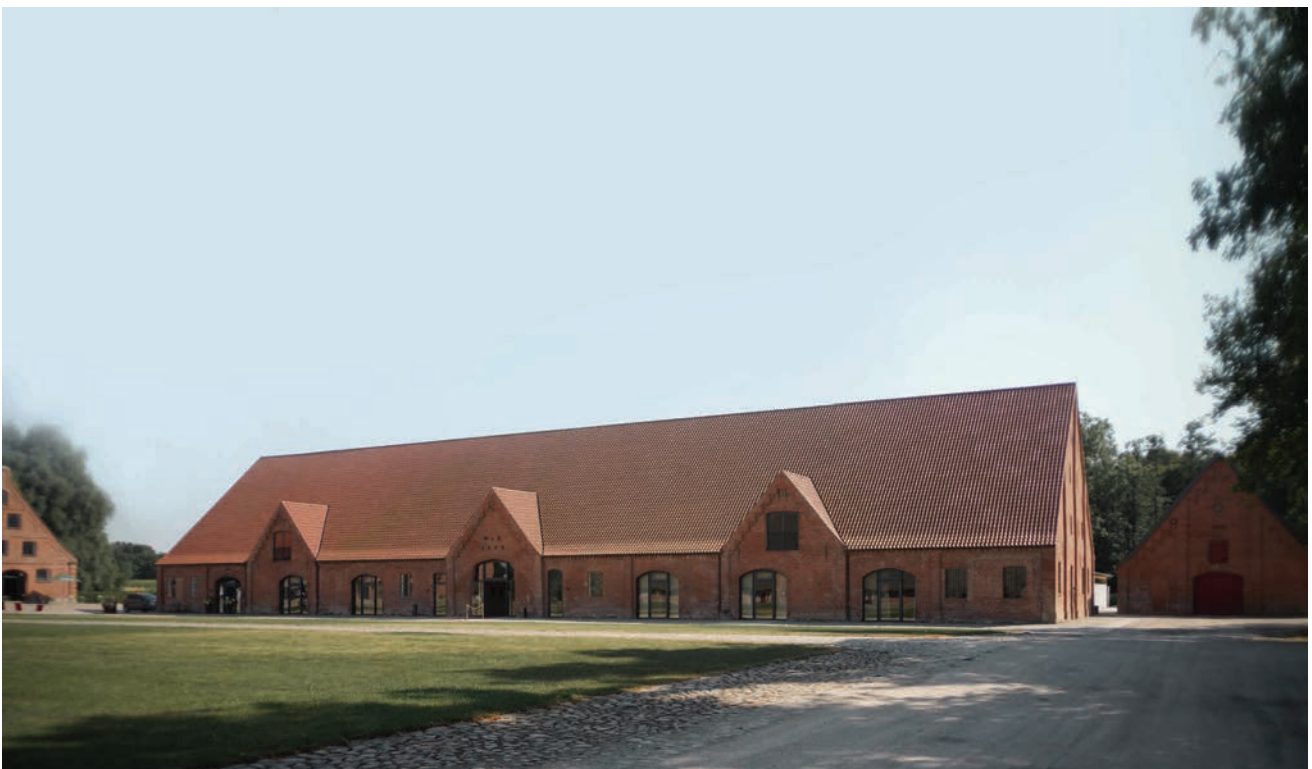
Abb. 3 Denkmalgeschützte Nordfassade mit Ausrichtung zum Werkhof
