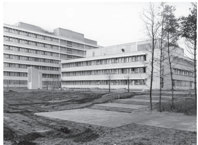
Abb. 8 Außenaufnahme des ehemaligen Stasi-Krankenhauses
