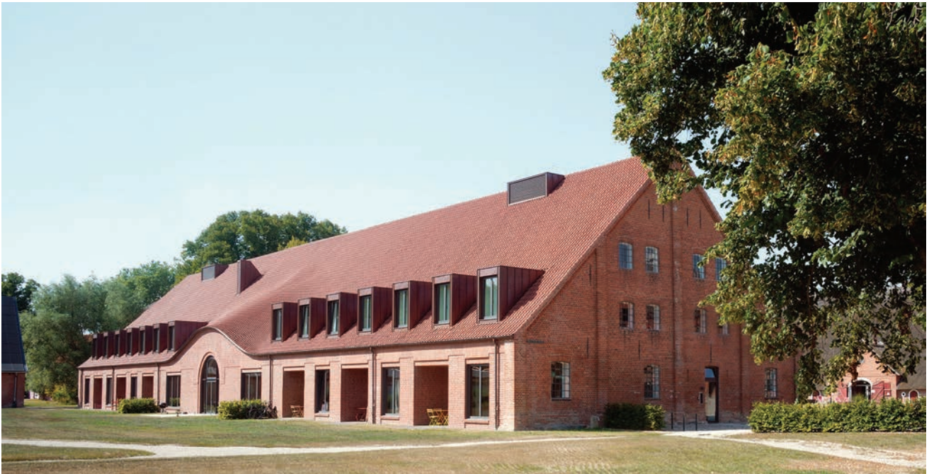
Abb. 2 Neu errichtete Südfassade mit semiprivaten Aussenräumen
