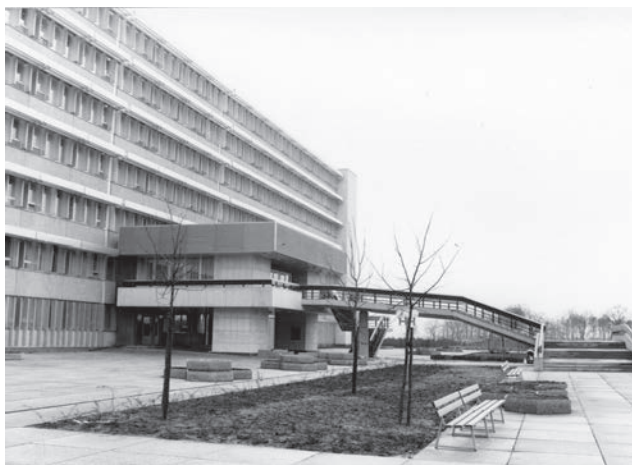
Abb. 3 Außenaufnahme des ehemaligen Stasi-Krankenhauses
