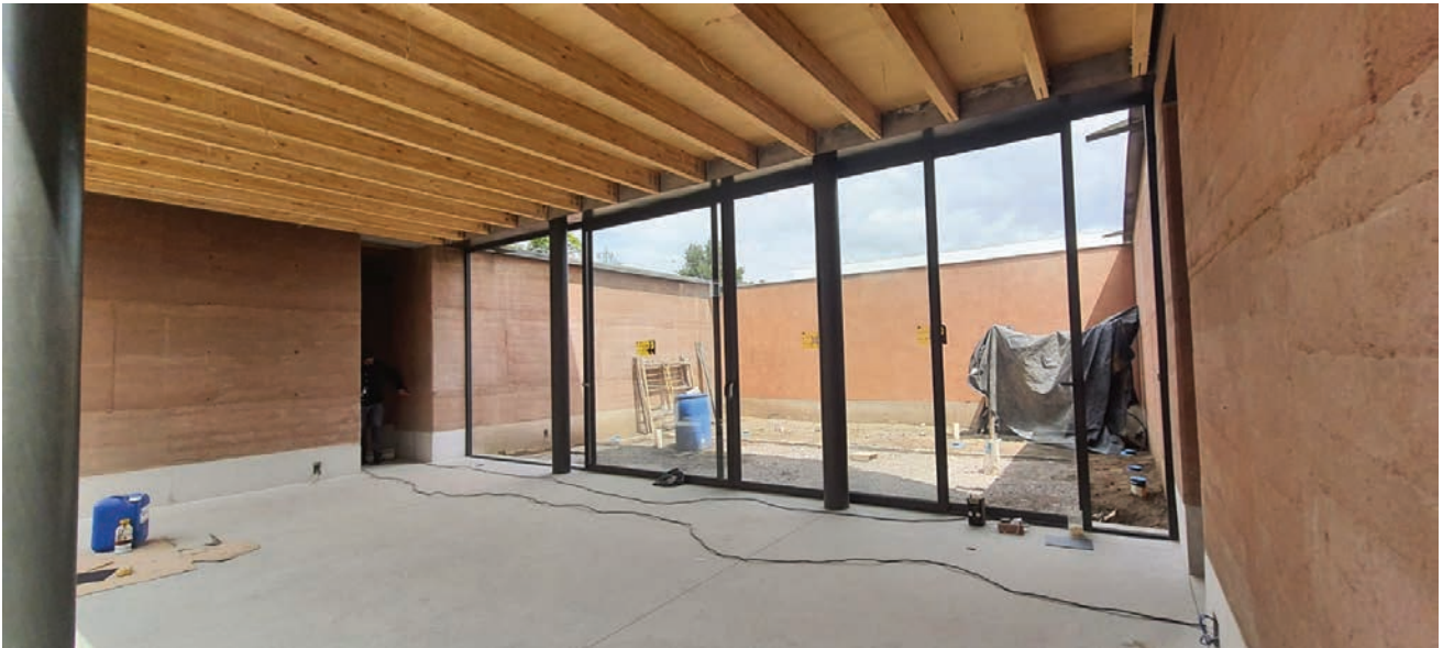
Abb. 4 Inneraum. Die massiven Stampflehmwände stehen auf einem Betonsockel. Die äußerste Schicht der recyclefähigen Wände besteht aus einem mitgestampften Lehm- Kalkputz.
