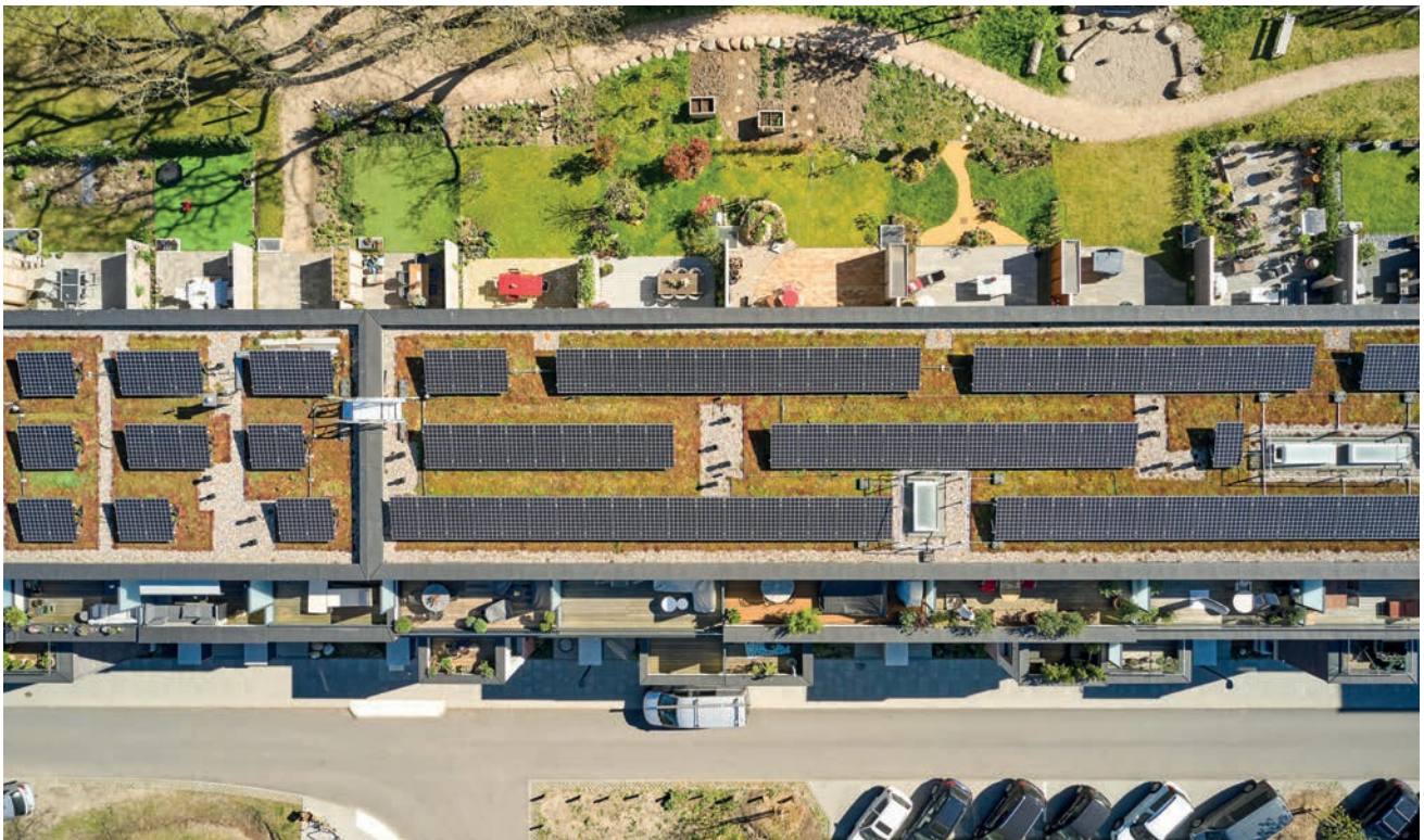
Abb. 3 Luftbild Foto: Claus Morgenstern
