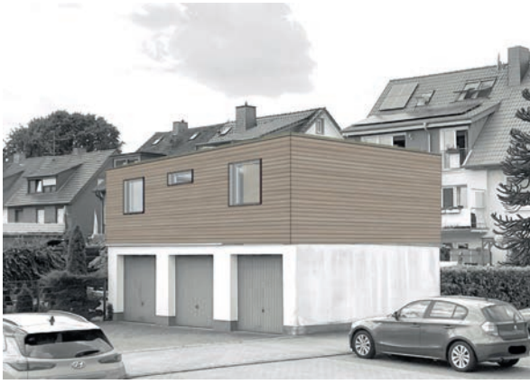
Abb. 5 Aufstockung bestehender Garagen
